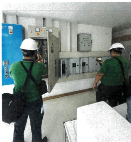
(ญ) การตรวจสอบระบบไฟฟ้าโดยวิศวกรไฟฟ้าที่ได้รับอนุญาตภายในโรงพยาบาล และบำรุงรักษาหม้อแปลงไฟฟ้า
